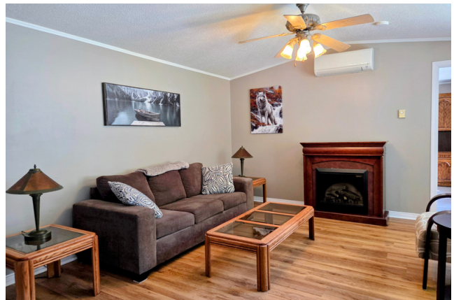
Heat pump + ceiling fan
